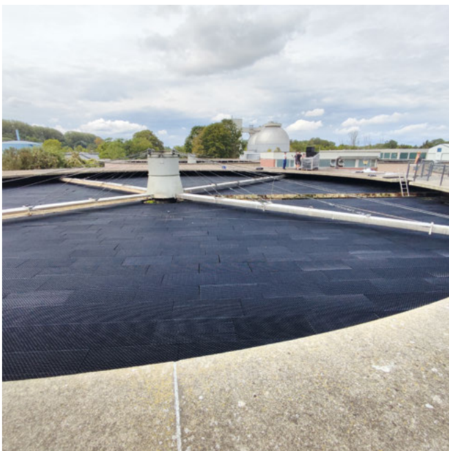
Abb. 1: Der Tropfkörper mit den ausgelegten Tropfenabscheidern (Foto ZKA)
