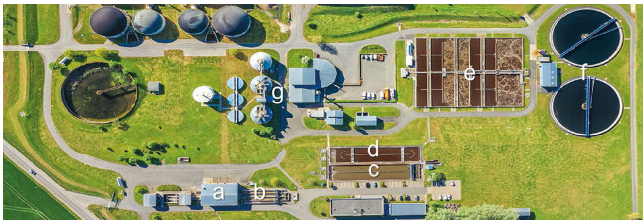
Abb. 1: Luftbild der Kläranlage Jena (Bild: Zweckverband JenaWasser) mit (a) Rechenhaus, (b) Sand- und Fettfang, (c) Vorklärbecken, (d) Anaerobbecken, (e) Kaskadenbelebung, (f) Nachklärbecken, (g) Schlammbehandlung
