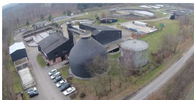
Abb. 1: Luftbild der Kläranlage, links vorne das überdachte Schneckenhebewerk
