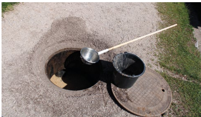
Abb. 5: Siebschöpfer zur Entnahme vom Schwimmschlamm (Eigenbau)
