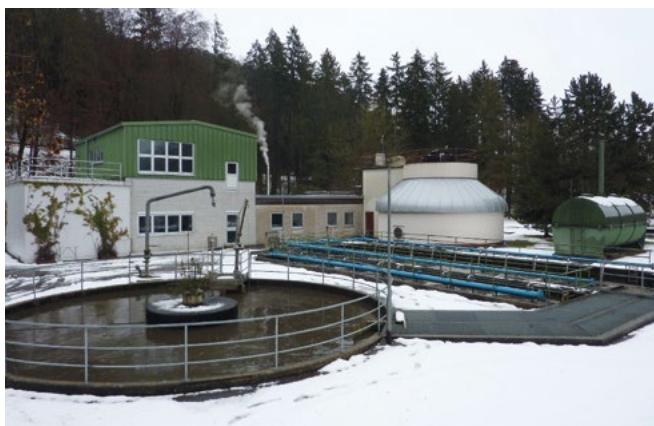
Abb. 1: Klein, aber auf hohem Niveau: die Kläranlage Fischingen
