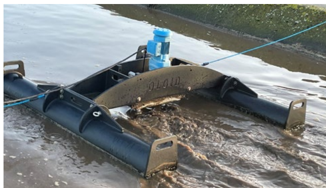
Abb. 4: Das neue Rührwerk im Einsatz
