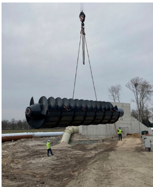
Titelbild: Eine tonnenschwere Schnecke auf Reisen zu ihrem Einbau in das Zulaufgerinne der Wasserbehandlungsanlage bei Plessa in Brandenburg (Foto: Gert Krimmling)
