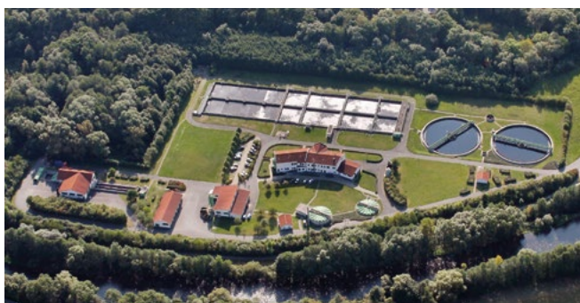
Abb. 1: Die Kläranlage in der ersten Ausbaustufe, das Einleitgewässer ist die Saale.
