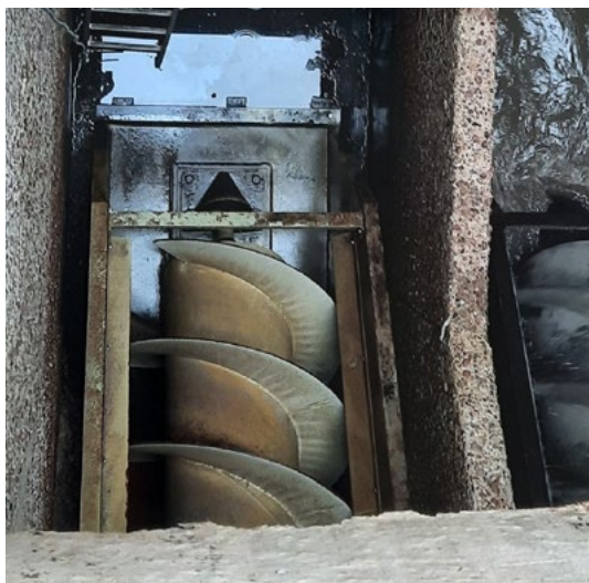
Abb. 4: Jetzt kann das erste Fußlager gewartet und der Lagerwechsel vorgenommen werden
