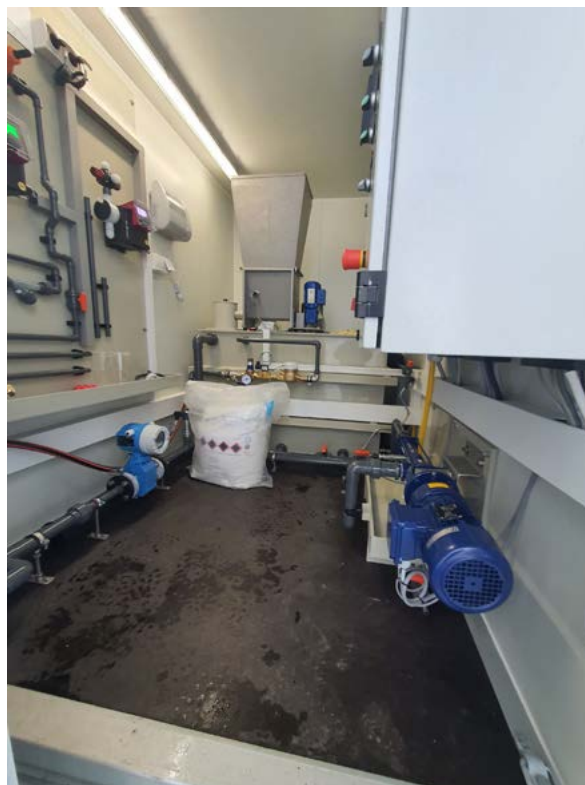
Abb. 5: Einheit mit Dosierstation und Verbindungsschläuchen
