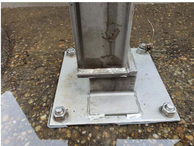
Abb. 12: Erneuerung der Grundplatte
