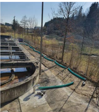
Abb. 9: Die Schlauchleitungen werden angeschlossen
