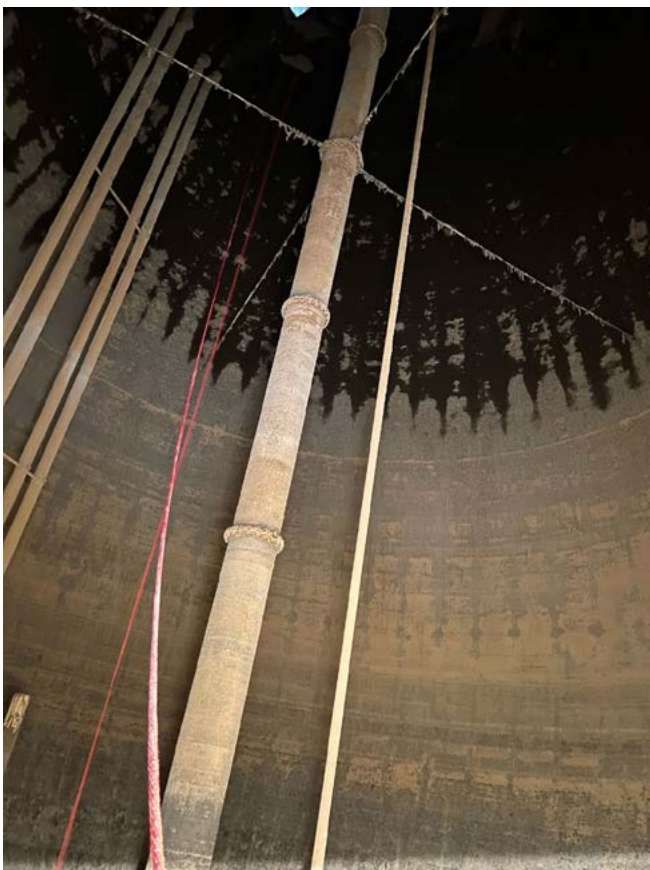
Abb. 3: Begutachtung des Mischerrohrs
