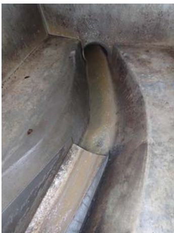
Abb. 4: Ergänztes Gerinne, nach der Sanierung, mit Abfluss
