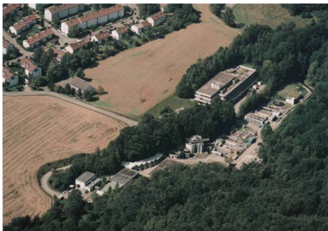
Abb. 1: Das Lehr- und Forschungsklärwerk der Universität Stuttgart (Foto: iswa.uni-stuttgart)
