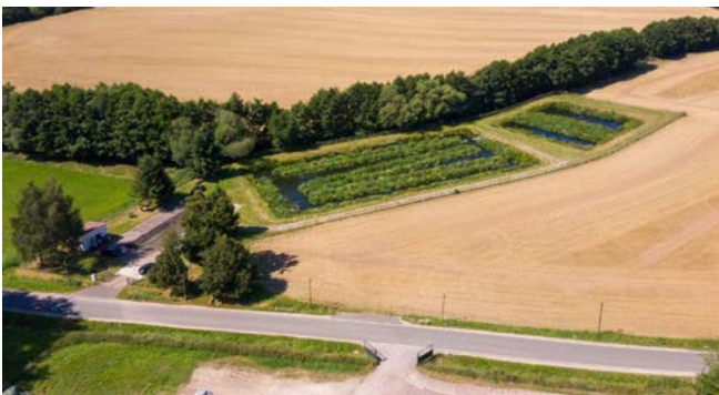
Abb. 1: Luftaufnahme der Teichkläranlage Günterode im Herbst 2020
