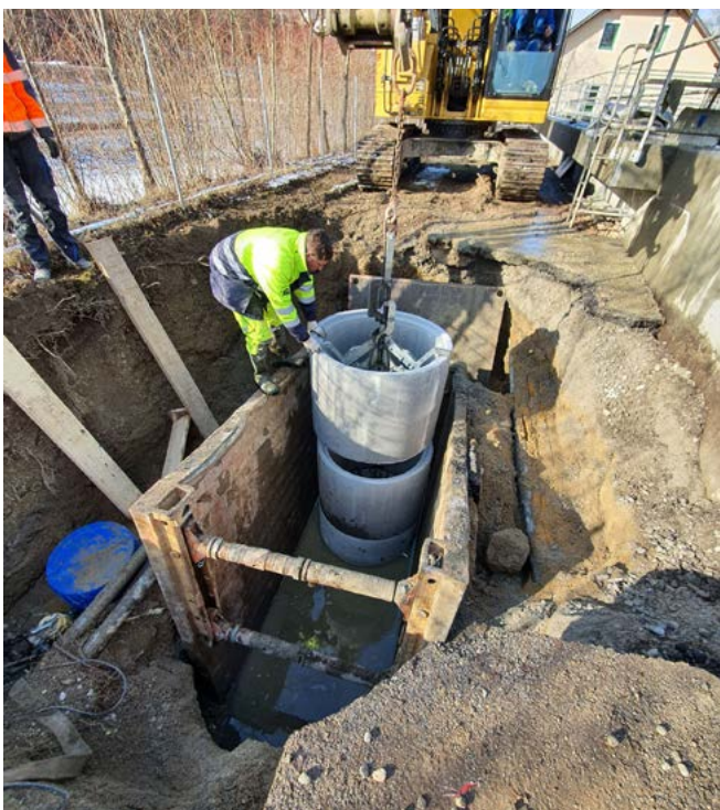
Abb. 7: Vier Meter tief werden die Brunnen gesetzt.
