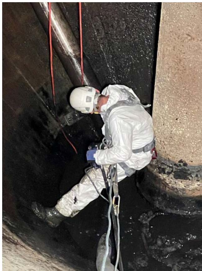
Abb. 4: Einsatz der Kletterer zur Restentleerung
