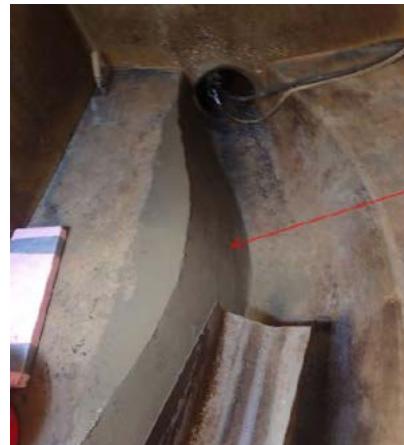
Abb. 3: Ergänztes Gerinne, nach der Sanierung, ohne Abfluss
