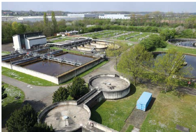
Abb. 1: Die Kläranlage Köln-Langel
