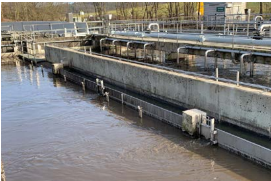
Abb. 4: Fertige „Deni-Rinne“ mit drei Auslassschiebern
