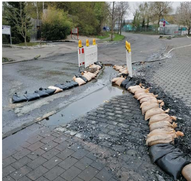
Abb. 10: Sammelstelle für wild abfließendes Löschwasser
