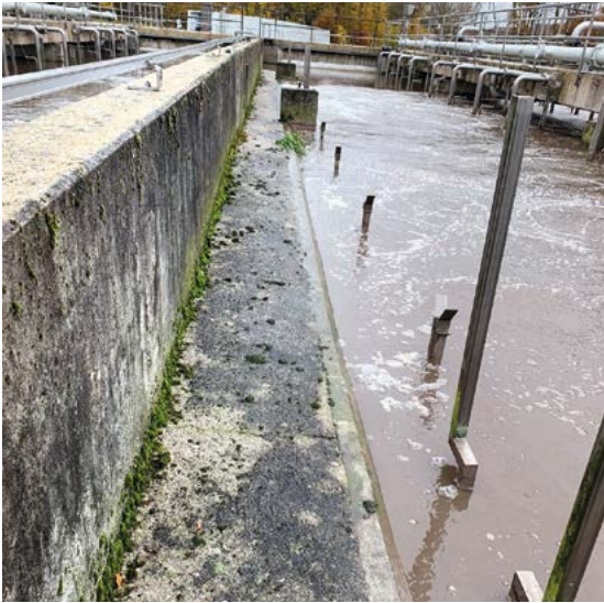
Abb. 3: Vorhandene Betonkonstruktion vor dem Umbau
