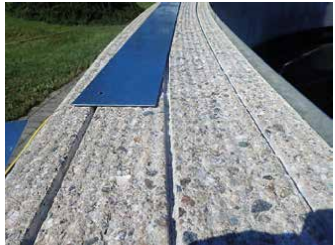
Abb. 5: Fräsen der Nuten für Heizleitungen
