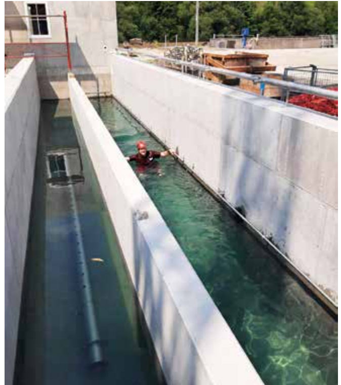
Abb. 1: In voller Ausrüstung im Sandfang
