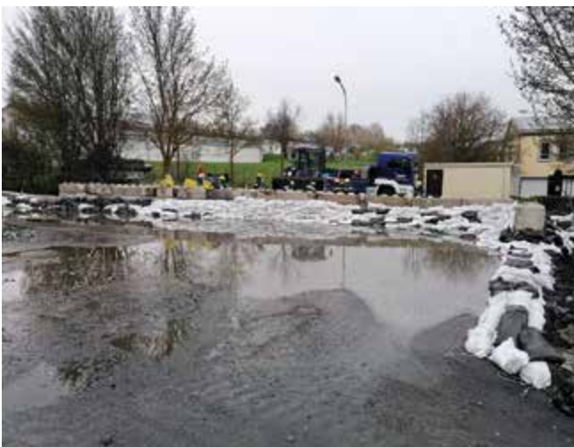
Abb. 9: Sandsäcke und Betonblocksteine als Bollwerk
