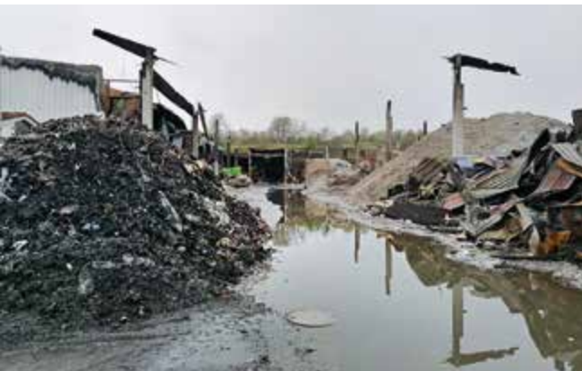
Abb. 3: Probleme mit dem Löschwasser
