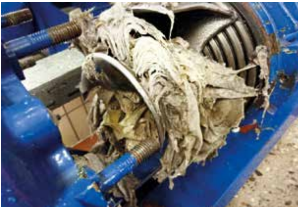
Abb. 6: Pumpe mit Wartungsschlitten
