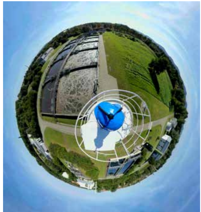
Abb. 5: Unsere Welt die Kläranlage
