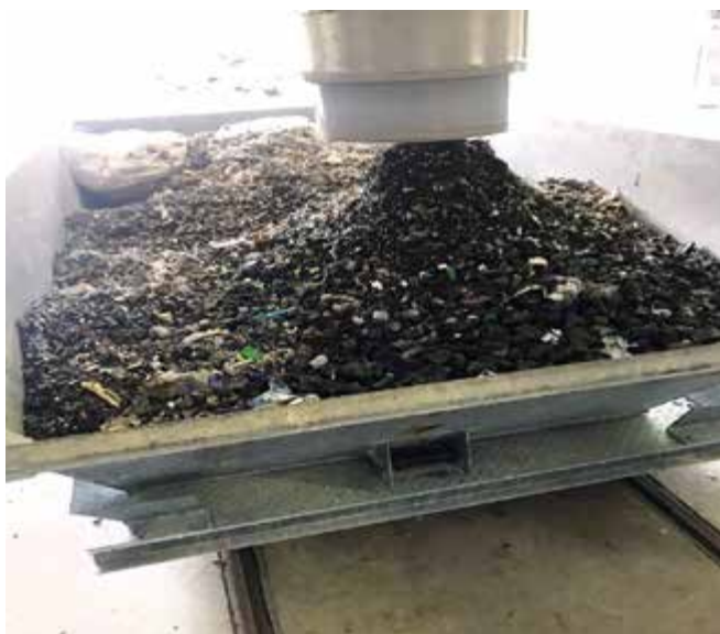
Abb. 6: Rechengut mit geschredderten Kunststoffteilchen
