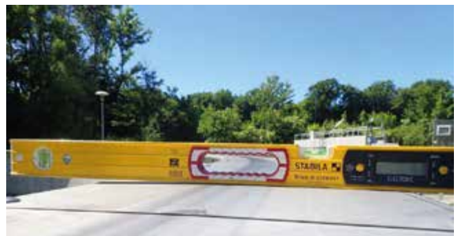
Abb. 10: Quergefälle auf der Metallabdeckung ca. 1 %
