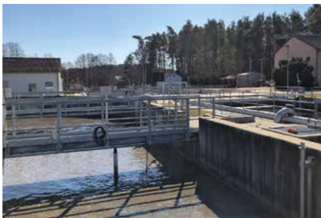
Abb. 1: Die Kläranlage Hilpoltstein
