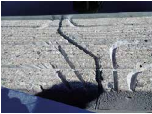
Abb. 7: Austrittspunkt der Heizkabel zum Schaltschrank
