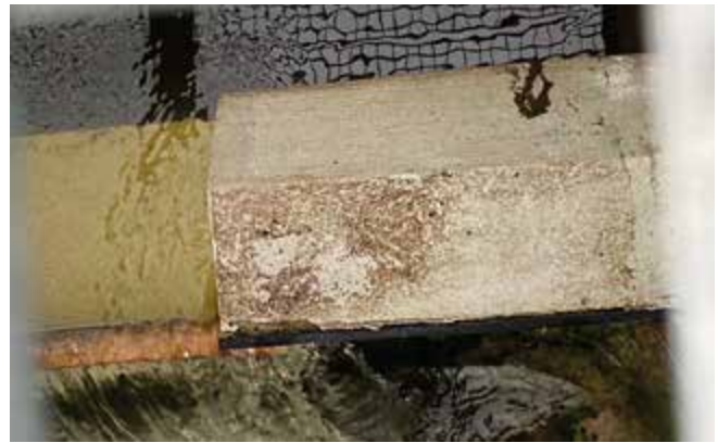
Abb. 3: Bretterwand für den Klarwasserablauf
