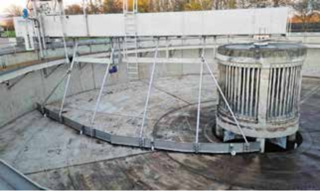
Abb. 6: Das Nachklärbecken kurz vor dem Abschluss der Sanierungsarbeiten
