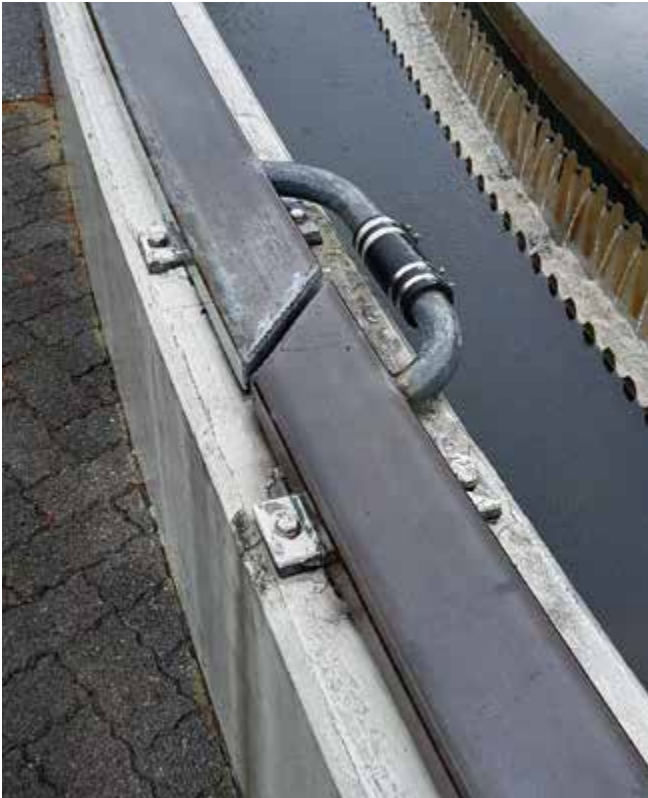
Abb. 3: Laufbahn der Nachklärbecken
