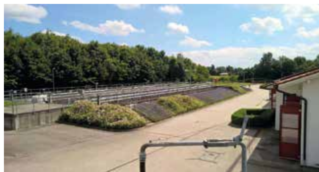
Abb. 2: Drei parallel laufende Belebungsbecken
