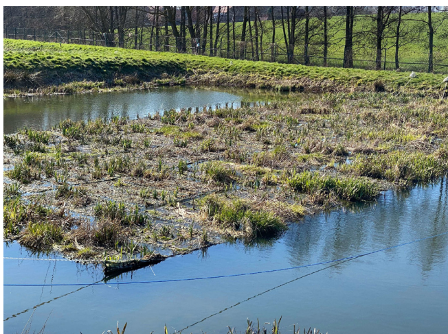
Abb. 2: Einbau der Schilfmatten Oktober 2019
