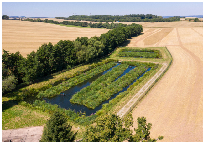
Abb. 3: Kläranlage Günterode September 2020
