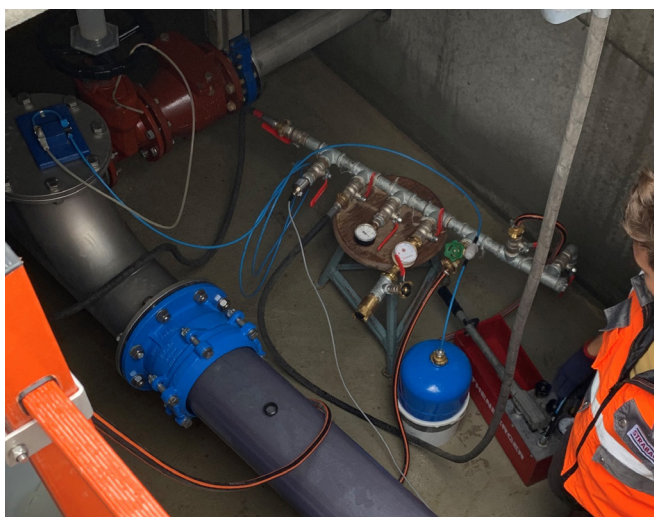
Abb. 1: Durchführung einer Druckprüfung im Rahmen des Forschungsprojekts
