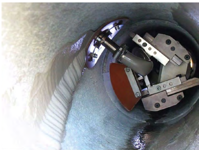
Abb. 7: Schadenbehebung: ein Sanierungsroboter beim Spachteln einer Rohrleitung
