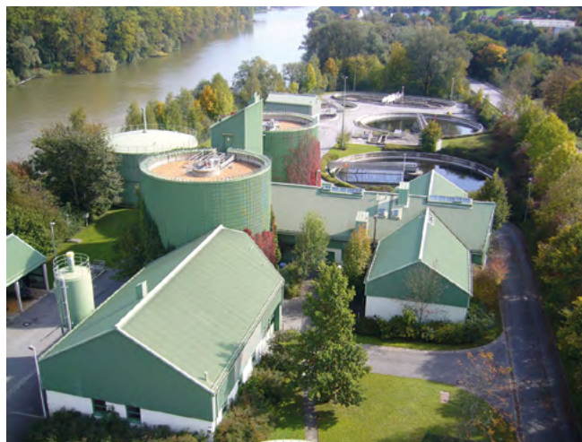
Abb. 1: Kläranlage Vilshofen unmittelbar an der Donau
