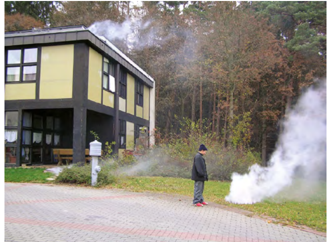
Abb. 14: Viele Kommunen klagen über Fremdwasser. Bei der Suche nach den Ursachen hilft als erste Orientierung ein Rauchttest, um diese Fehlanlüsse feststellen zu können.
