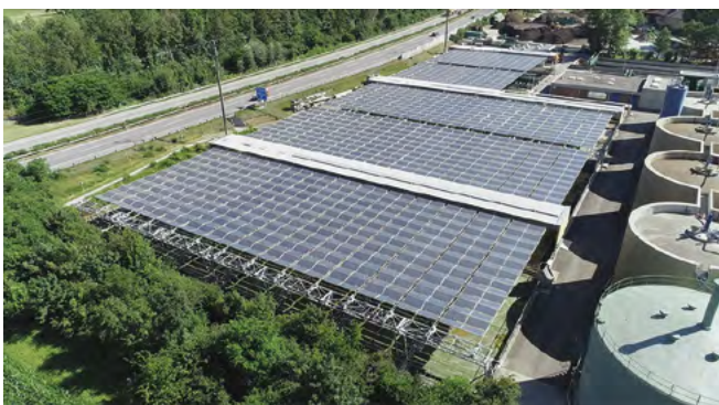
Abb. 2: Das Solarfaltdach wird durch den Faltmechanismus vor Sturm, Hagel und Schnee geschützt und vermeidet damit statische Kräfte. Dies erlaubt sehr weite Stützenabstände und große Höhe über Boden. Hier die ARA Chur bei schönem Wetter.
