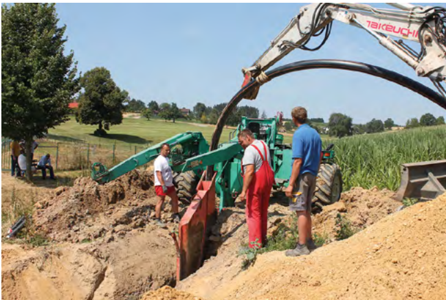
Abb. 1: Für den Anschluss von Ortsteilen im Trennsystem im ländlichen Bereich hat sich das Einpfügen von Rohrleitungen mit kleinen Durchmessern bewährt.
