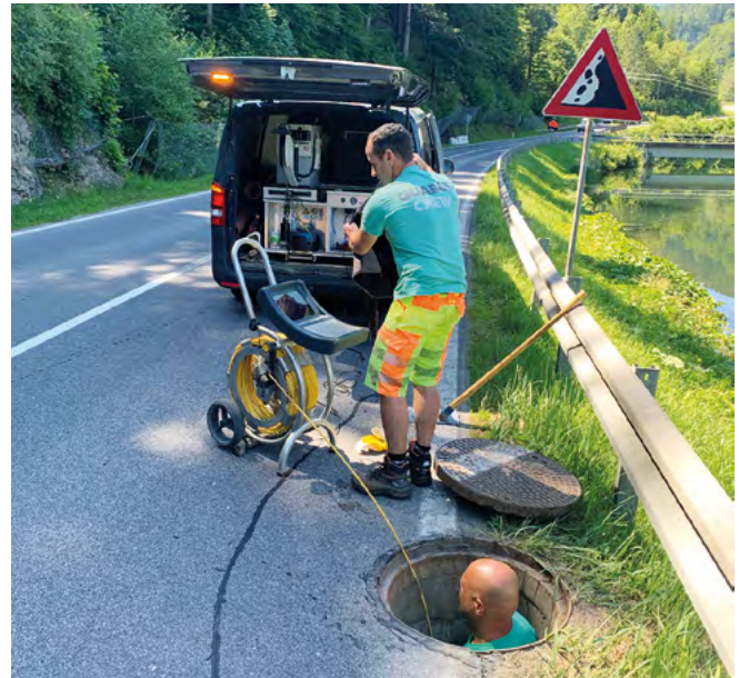
Abb. 4: TV-Inspektion mittels Schiebekamera bei Zwischenschacht
