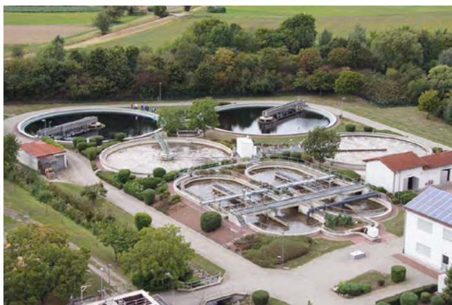
Abb. 1: Gesamtansicht der Kläranlage Bickenbach
