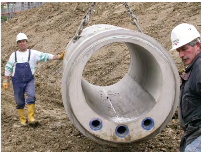
Abb. 2: Hier wird nicht nur für die Abwasserableitung gesorgt, sondern gleichzeitig auch an die Versorgung gedacht, wie das Verlegen von Glasfaserkabeln u. ä.
