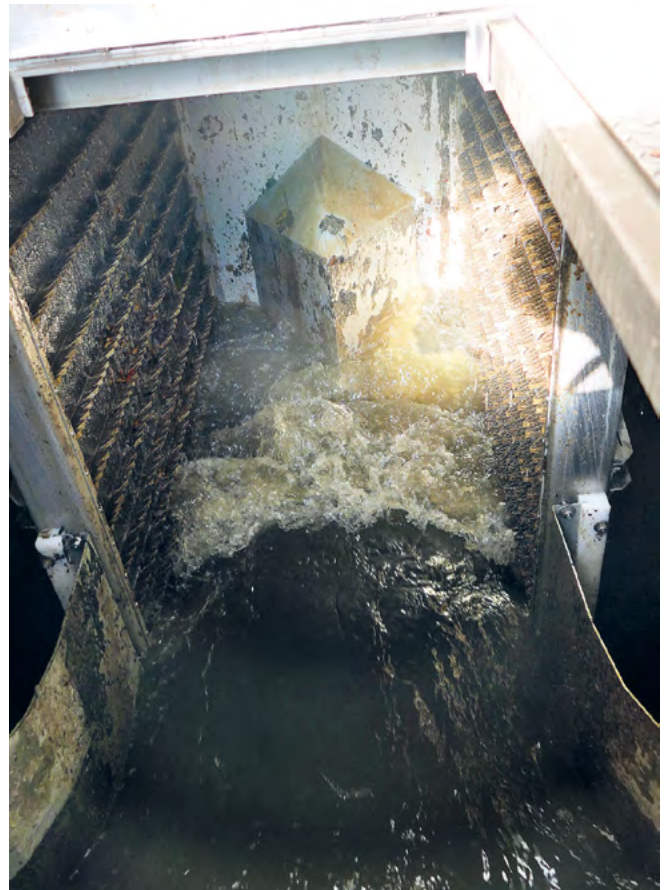
Abb. 3: Einlauf des Rohabwassers in die Maschine
