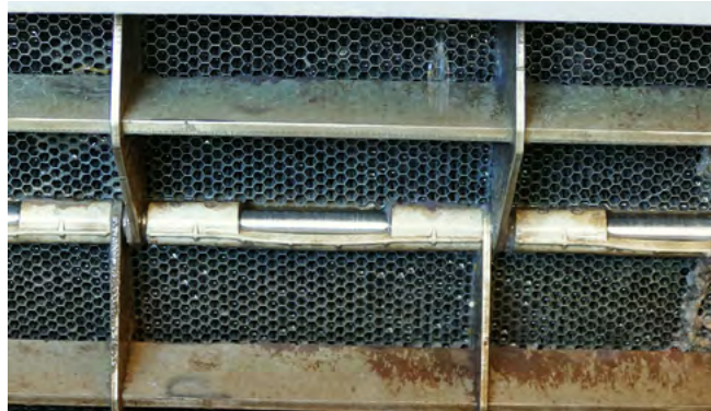
Abb. 5: Wabengewebe nach Abreinigung von außen
