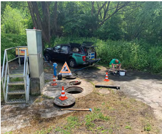
Abb. 3: TV-Inspektion mittels Kamerafahrwagen und separatem Vorspann
