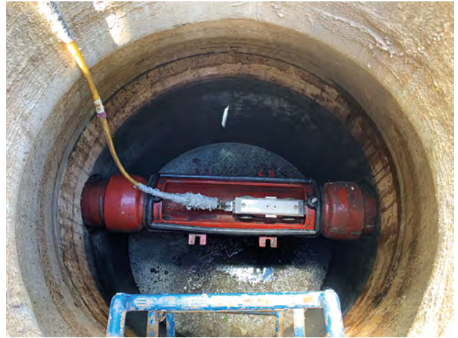
Abb. 7: Idealer Zwischenschacht. Kamera- und HD-reinigungs-tauglich
