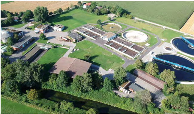
Abb. 1: Die Kläranlage Warthausen mit einer Ausbaugröße von 99 000 EW
