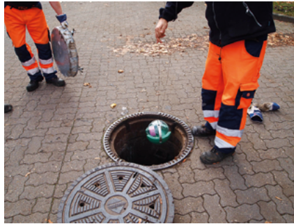
Abb. 6: Mitarbeiter der Stadt Karlsruhe beim Einbau der Rattenkugel
