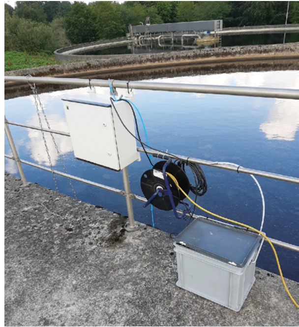
Abb. 5: Messanordnung beim Belebungsbecken 3
