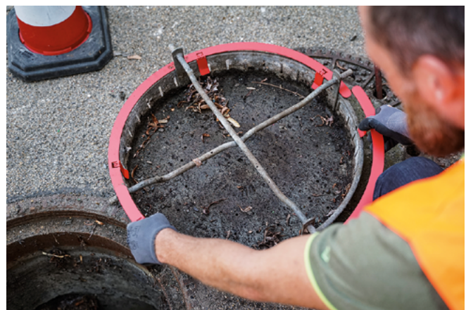
Abb. 2: Montieren des Halbrings auf dem Schmutzfangkorb
