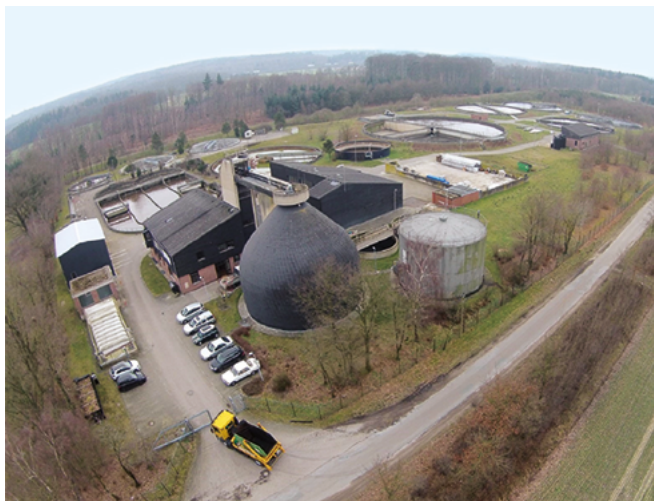
Abb. 1: Gesamtansicht der Kläranlage Püsselbüren
