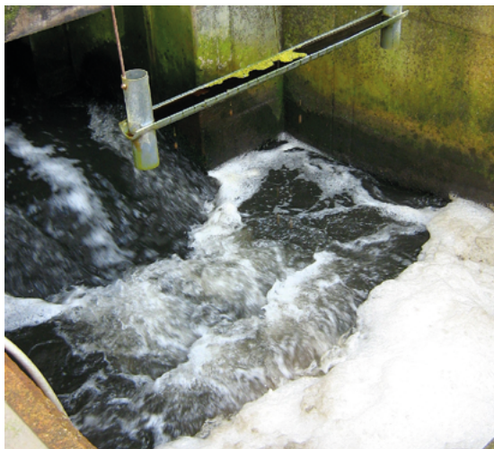
Abb. 3: Günstige Dosierstelle Ablauf Tropfkörper
