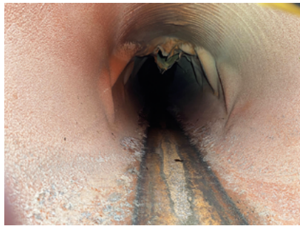
Abb. 4: Deformierter Hauptkanal (vom Auslass her fotografiert)
