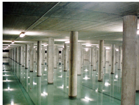
Abb. 14: Gigantisch! In diesem Regenrückhaltebecken unter einem Parkplatz können bis zu 90 000 m 3 Mischwasser gespeichert werden.
