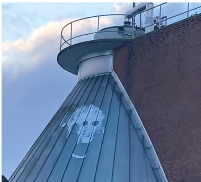
Abb. 2: Das Bild auf der Verkleidung des Faulbehälters
