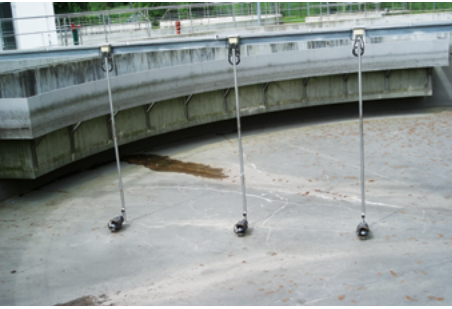
Abb. 7: Das schaut doch schon besser aus. Hier sorgen kleine Flügelräder für eine Spülwirkung.
