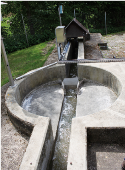
Abb. 3: Vom Regenüberlaufbecken führt ein offener Kanal zum Zerkleinerer.
