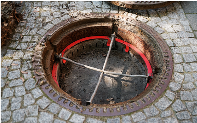
Abb. 3: Halbring, fertig nachgerüstet und eingebaut
