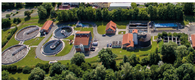
Abb. 1: Gesamtansicht der Kläranlage Neustadt mit einer Ausbaugröße von 32 500 EW
