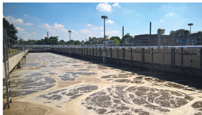
Abb. 3: Die Belebungsbecken wieder voll in Betrieb
