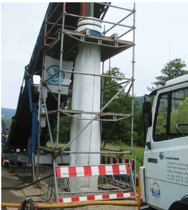
Abb. 4: Der Inliner wird eingezogen.
