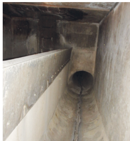
Abb. 3: Wehr, nachträglich mit Edelstahlschwelle ausgerüstet
