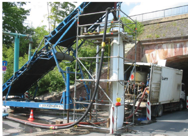
Abb. 5: An vielen Problemstellen musste gearbeitet werden.
