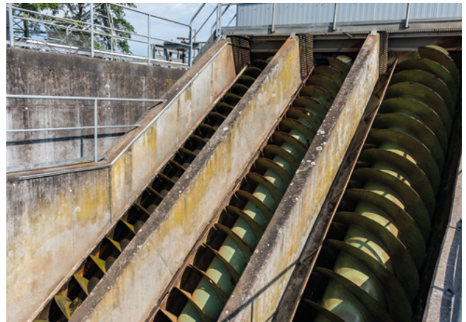
Abb. 2: Die Anlage vor der Sanierung
