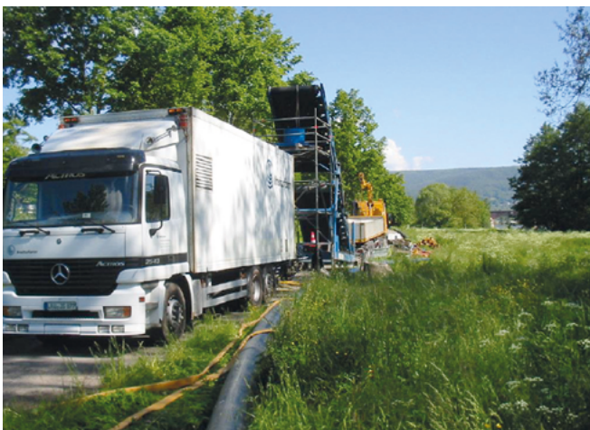
Abb. 3: Arbeiten im Uferstreifen des Mains
