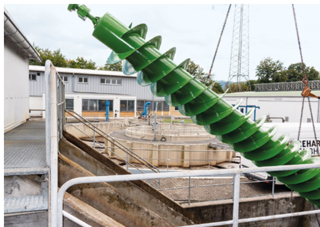
Abb. 6: Einbau der sanierten Hebeschnecke
