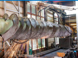
Sanierung einer Hebeschnecke Seite 3072
