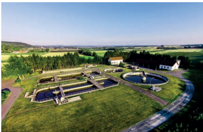
Die Verbandskläranlage mit einer Ausbaugröße von 15 200 EW
