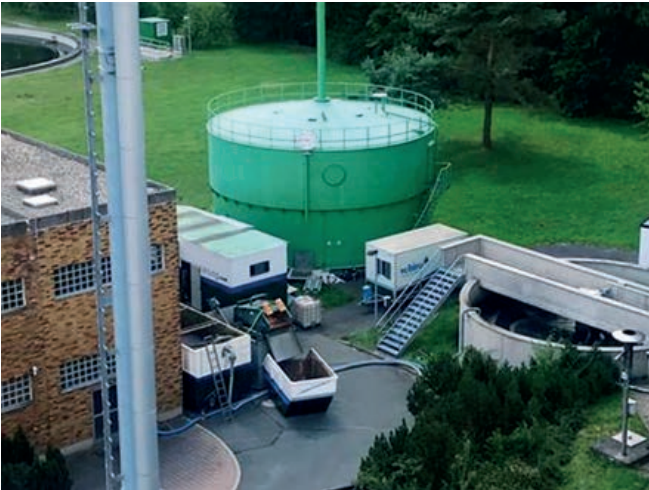
Abb. 7: Aufbau mobile Entwässerungsanlage
