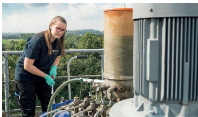
Abb. 1: Ist alles dicht? Insa prüft die Leitungen auf dem Faulbehälter (Foto: StEB Köln, Peter Jost)
