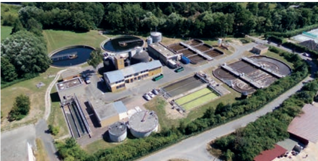
Abb. 1: Luftaufnahme der Kläranlage Taunusstein-Bleidenstadt
