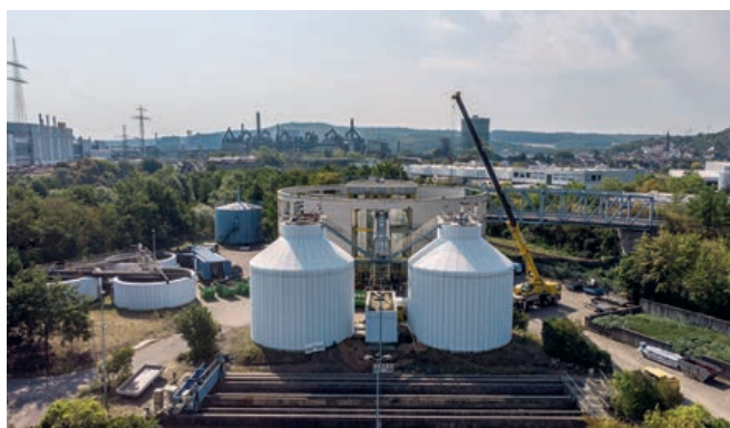
Abb. 1: Gesamtansicht der Kläranlage Völklingen mit einer Ausbaugröße von 80 000 EW
