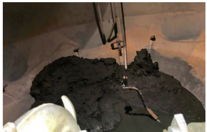
Abb. 10: Schlammablagerungen
