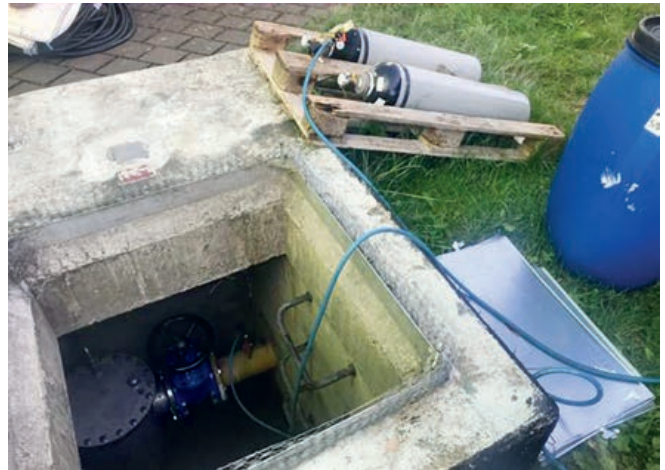
Abb. 5: Inertisieren der Gasleitung
