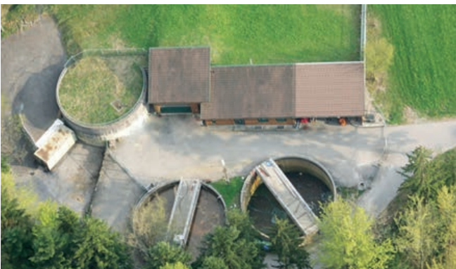
Abb. 1: Luftbild der Kläranlage Lingenau
