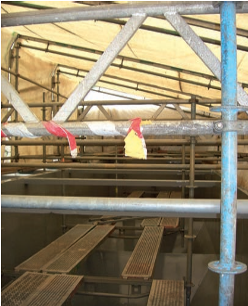
Abb. 3: Gerüstabdeckung
