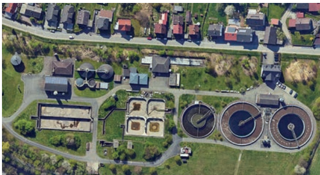
Abb.1: Luftaufnahme der Kläranlage
