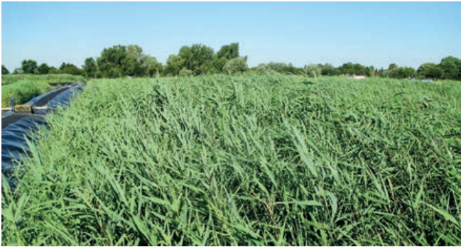
Abb. 2: Mithilfe von Sonne und Wind verdunsten die Schilfpflanzen über ihre riesige Blattoberfläche das Wasser und entwässern so den Schlamm.
