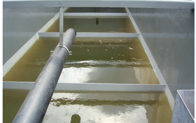
Abb. 4: Das neu beschichtete Nachklärbecken füllt sich mit Abwasser.
