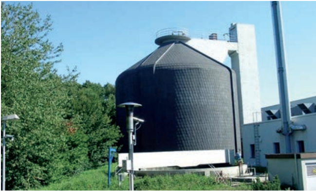
Abb. 1: Faulbehälter des Klärwerks Selb
