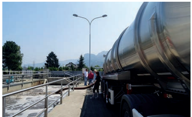
Abb. 3: „Belebtschlamminfusion“ in die Niederlaststufe der ARA Region Hohenems
