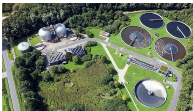
Abb. 1: Die Kläranlage Emden-Larrelt
