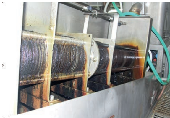
Abb. 7: Reparaturarbeiten bei der Schlamm-schneckenpresse
