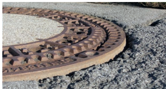
Abb. 8: Schachtsanierung durch den Klärwärter
