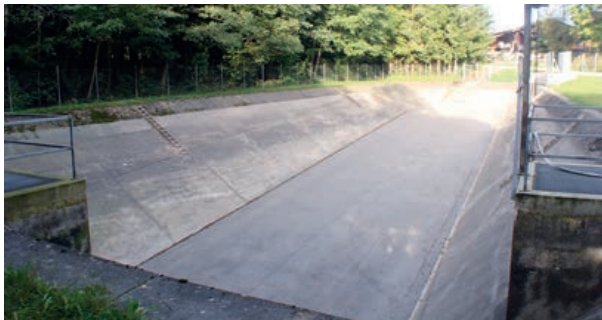
Abb. 2: Das Regenüberlaufbecken vor der Kläranlage
