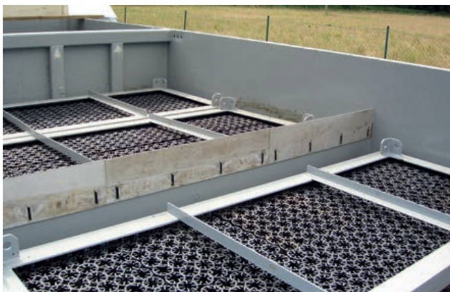
Abb. 5: Herausnehmbare Festbettkörbe
