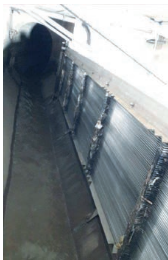
Abb. 5: Alles erledigt, das Rechengut ist auf dem Weg zur Kläranlage
