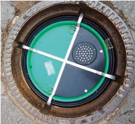
Abb. 5: Das Filtermaterial verhindert, dass Geruch austritt.
