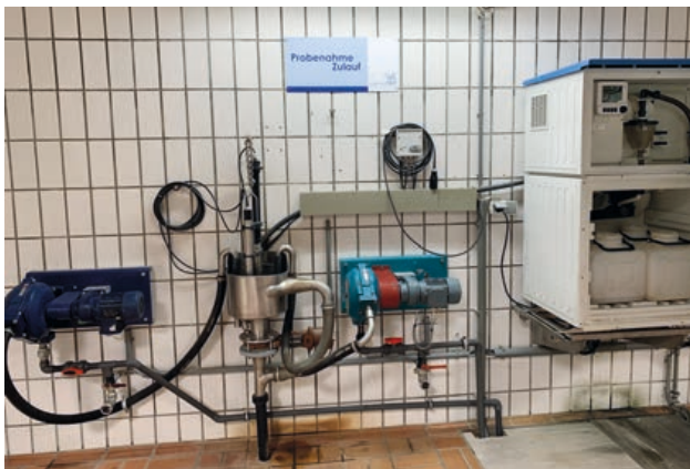
Abb. 2: Zwischen dem Sammelbehälter die beiden Schlauchquetschumpen (hell- und dunkelblau) und ganz rechts der Vakuumprobenehmer
