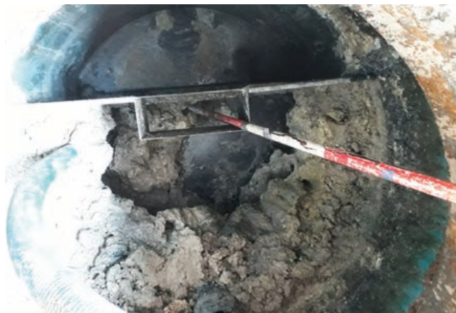
Abb. 1: Der Fettabscheider eines Golfclubs, der fünf Jahre nicht entleert wurde
