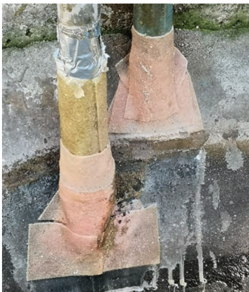
Abb. 1: Rohrabdichtung, zwar kein Schönheitspreis, aber effektiv
