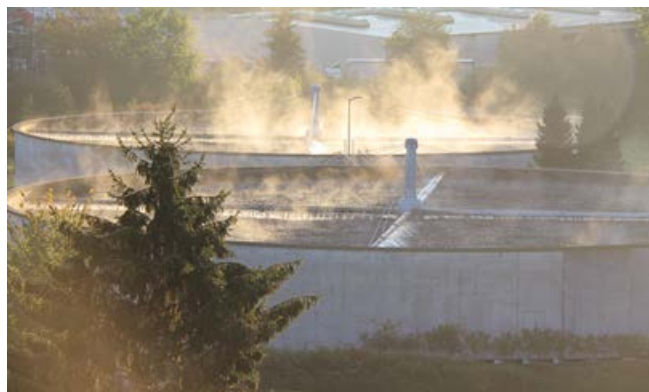
Die Kläranlage Böblingen-Sindelfingen im Morgennebel (Foto: Gert Schwentner)
