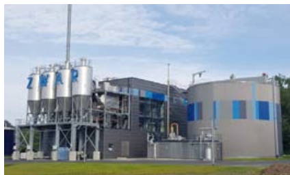
Abb. 4: Es ist so weit, die Realisierung der Klärschlammverwertungsanlage
