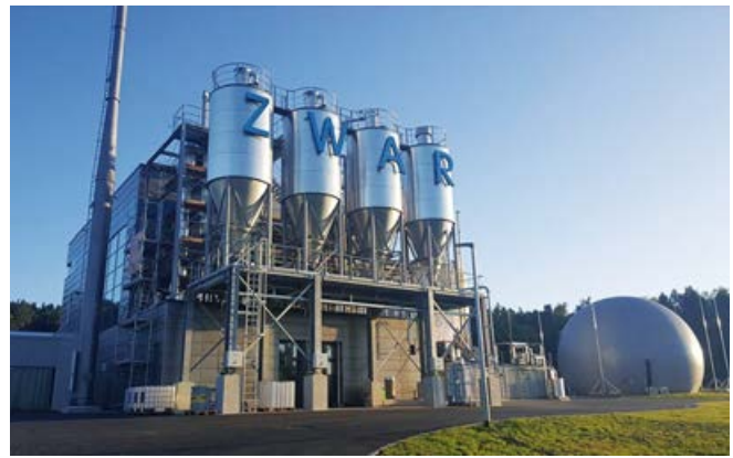
Abb. 7: Die Klärschlammverbrennungsanlage in Bergen auf Rügen
