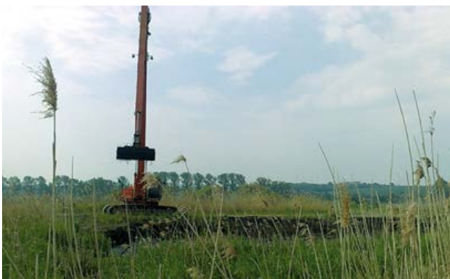
Abb. 2: Beräumung eines Schilfvererdungsbeetes
