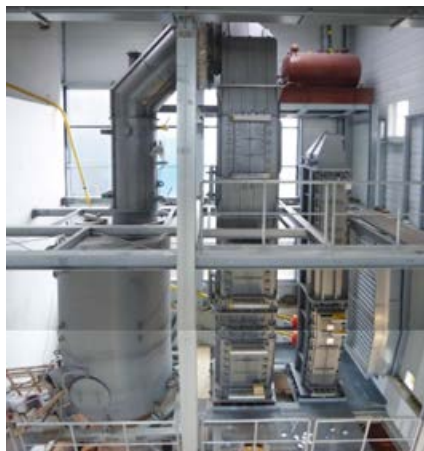
Abb. 5: Montierter Wirbelschichtofen
