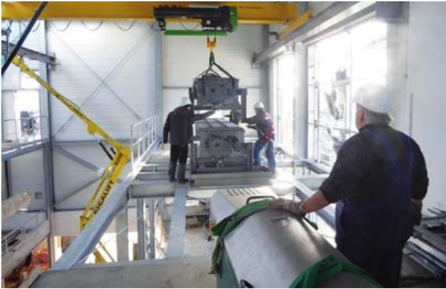
Abb. 6: Montage des Schneckenrockners
