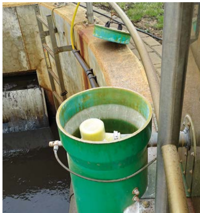
Abb. 4: Abwurfrohr im Schutzrohr mit Dosierschneckenaustrag, oben zu sehen ist der Deckel
