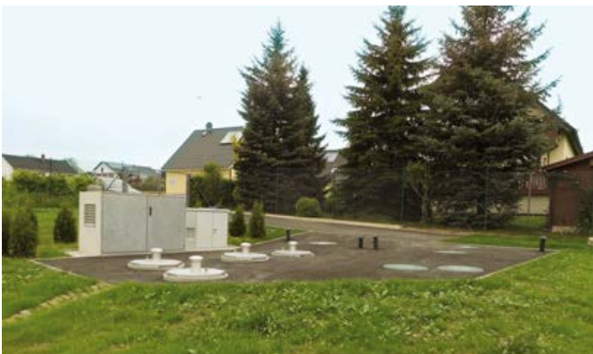
Abb. 2: Kommunale Kläranlage für 200 EW nach der Sanierung
